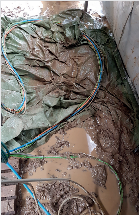
Bild 10: Lichtleitfaser Schlauchpaket im durchnässten Boden
