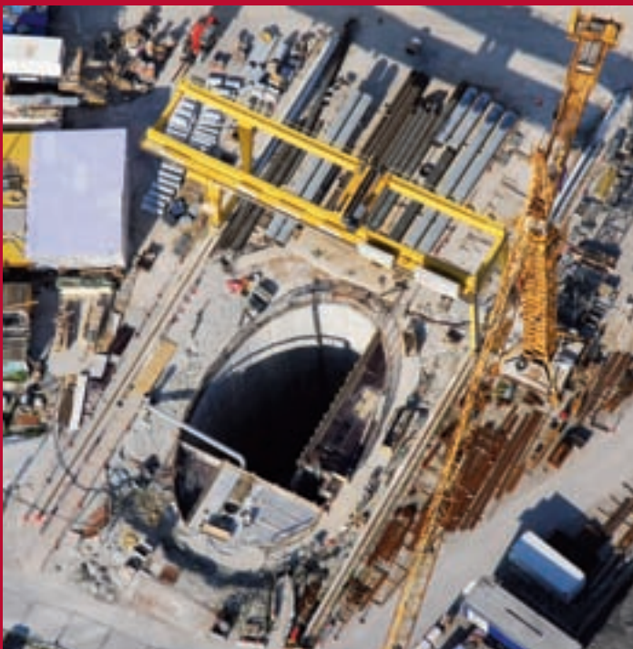
Der ovale Startschacht mit einer Tiefe von 35 m
