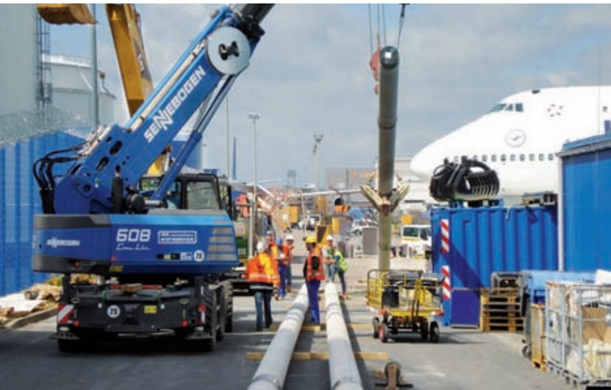
Verlegearbeiten der Firma Nacap am Frankfurter Flughafen
