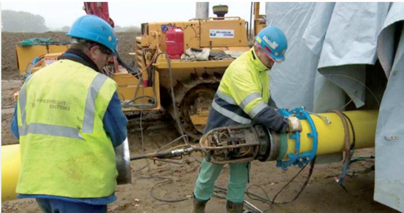
Justierungsarbeiten zweier Stahlrohre auf der Baustelle
