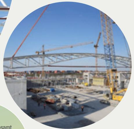
Spektakuläre Millimeterarbeit: Insgesamt dreizehn Dachträger pro Halle wurden auf die Seitenwände der künftigen Hallen C5 und C6 per Kran justiert. Die Stahlkonstruktionen waren bis zu 92 Tonnen schwer.
