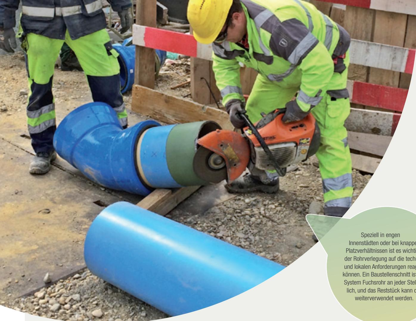
Speziell in engen Innenstädten oder bei knappen Platzverhältnissen ist es wichtig, bei der Rohrverlegung auf die technischen und lokalen Anforderungen reagieren zu können. Ein Baustellenschnitt ist mit dem System Fuchsrohr an jeder Stelle möglich, und das Reststück kann direkt weiterverwendet werden.
